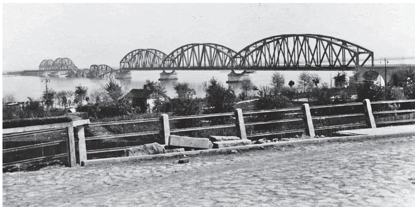
Поврежденный мост короля Петра II (Частная коллекция Душана Напьяла)
