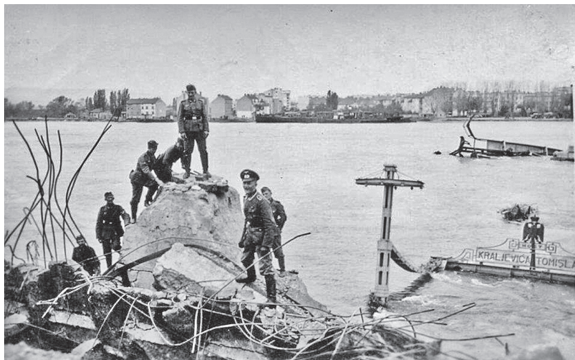
Разрушенный мост Королевича Томислава (Частная коллекция Душана Натияла)
